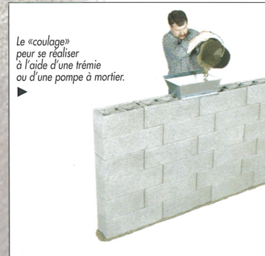
▲ L'empilage s'effectue à sec sur six rangs environ en respectant la superposition des alvéoles permettant d'assurer le «coulage». (hauteur d'étage pour coulage à la pompe).
