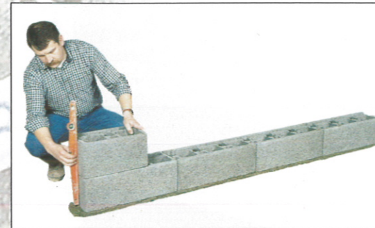
▲ Le contrôle d'aplomb se fait uniquement sur les abouts de l'ouvrage.
