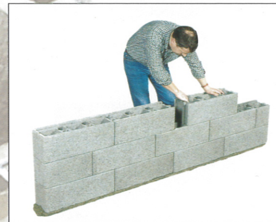
▲ L'empilage s'effectue à sec sur six rangs environ en respectant la superposition des alvéoles permettant d'assurer le «coulage». (hauteur d'étage pour coulage à la pompe).
